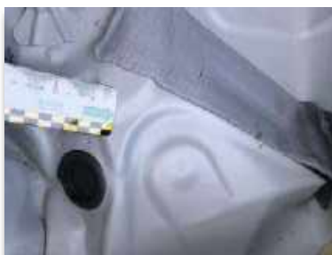
Deformazioni interne evidenti
